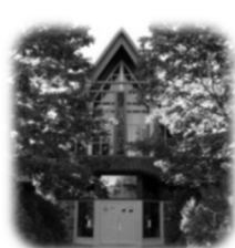
Église Saint-Pierre 87, chemin du Fleuve, Pointe-des-Cascades
